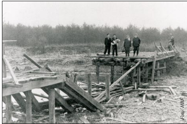
Bei der von den Sowjets gesprengten Brücke von Andau.
